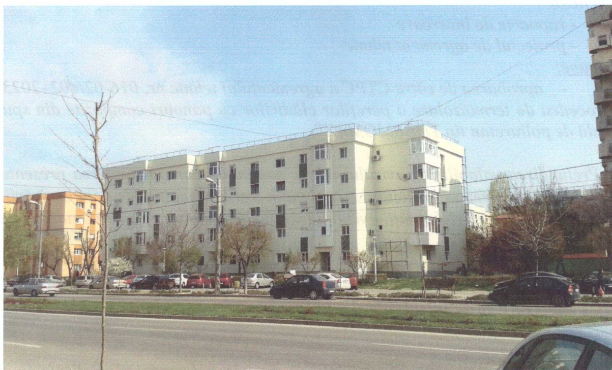
Figura nr. 14 – Bloc M19 –(Craiova) Vedere de ansamblu a blocului placat cu panouri THERMOMAX , an 2016
